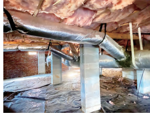
Crawl Space 裡貼著地板的是粉紅色絕緣保暖物品
