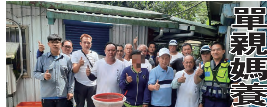
圖：吉安警分局池南派出所集結新秀義工隊、秀蓮鄉民代與安那共工程行等協助修繕單親媽養六子居家排水管。(池南派出所提供)
