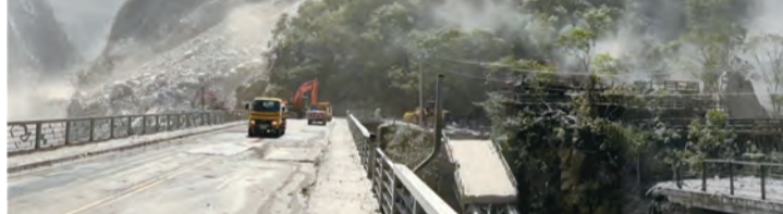
圖：震後不斷，太魯閣與花蓮受災民眾，紛紛進入災後不安定期。(174.1k坊方道路阻斷照片，太魯閣工務段提供)
