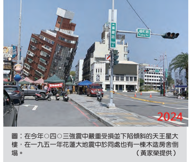
2024 圖：在今年〇四〇三強震中嚴重受損並下陷傾斜的天王星大樓，在一九五一年花蓮大地震中於同處也有一棟木造房舍倒塌。(黃家榮提供)
