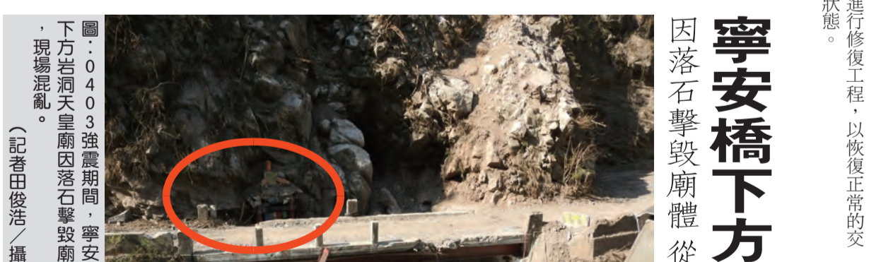
圖：0403強震期間，寧安橋下方岩洞天皇廟因落石擊毀廟體，現場混亂。(記者田俊浩/攝)
