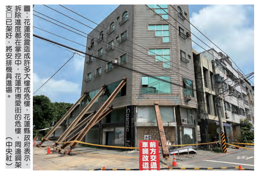
圖：花蓮強震造成許多大樓成危樓，花蓮縣政府表示，拆除進度都在掌控中，花蓮市博愛街的危樓，周邊鋼架支柱已架好，將安排機具進場。(中央社)
