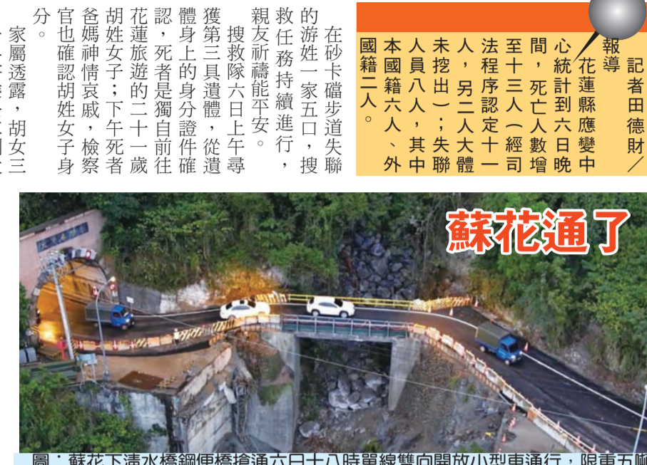
圖：蘇花下清水橋樑便橋搶通六日十八時單線雙向開放小型車通行，限重五噸夜間封路。(東區養護工程分局提供)
