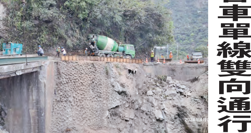
圖：蘇花搶災團隊克服蘇花下清水橋便橋施做，預估六日十八時開放小客車單線雙向通行。(公路局東區養護工程分局提供)
