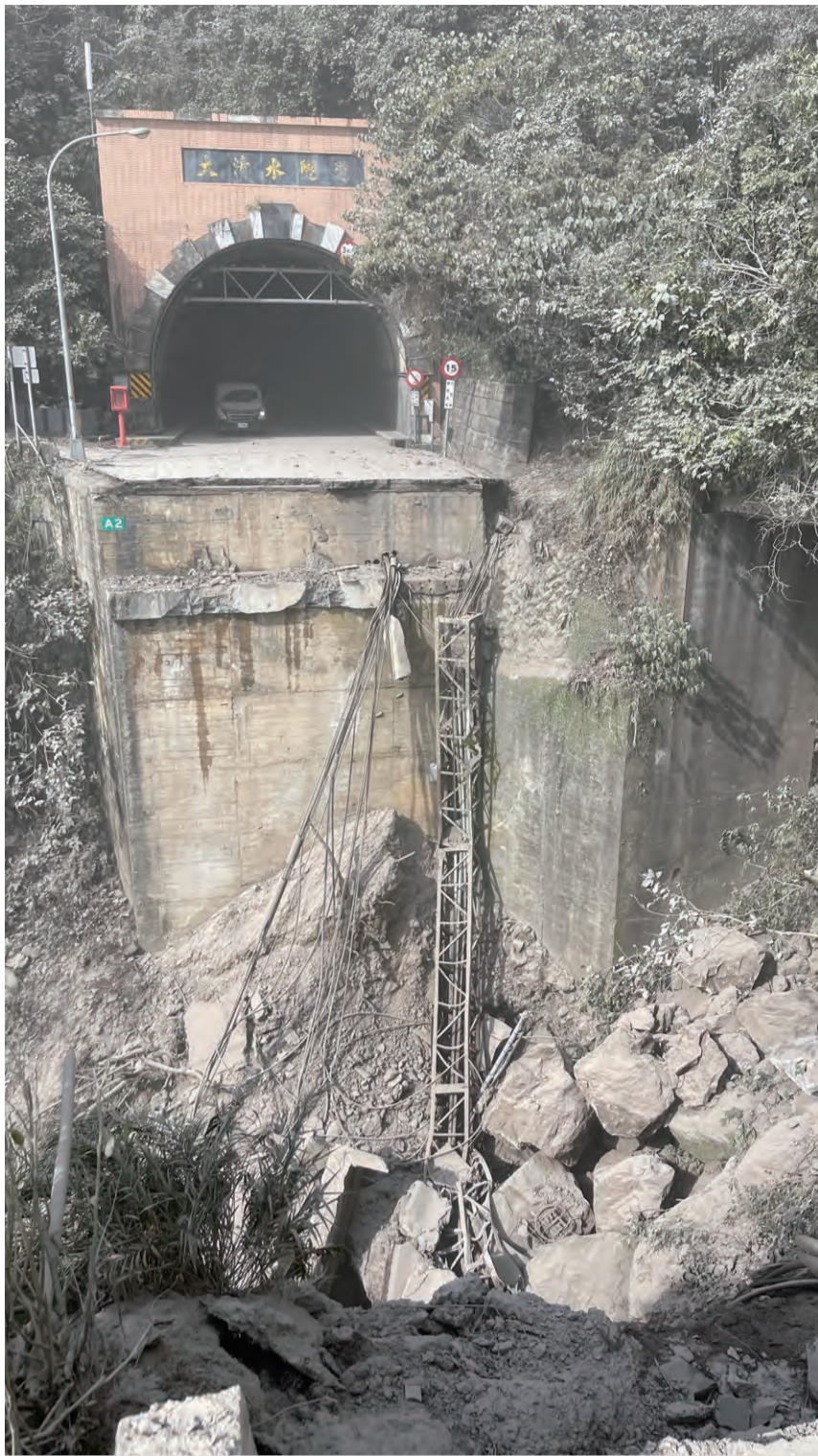
蘇花災情慘重全線封閉，其中二十米大清水橋坍塌「路基消失」。
